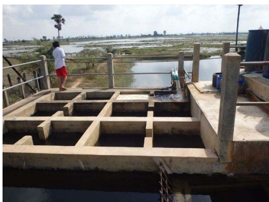
宇流式沈殿池
