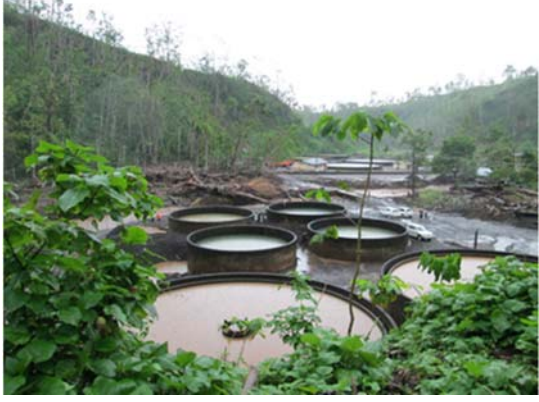
写真.濁水が流入した浄水場
