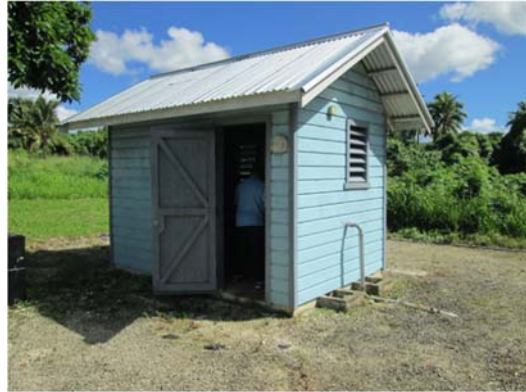
写真.ポンプ室
