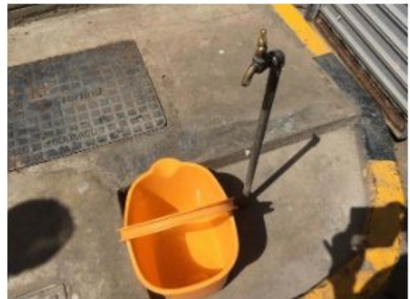
現場で見つけた水道管
