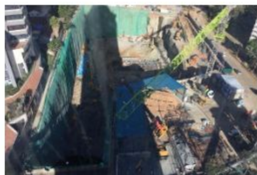
建設中の高層ビル
