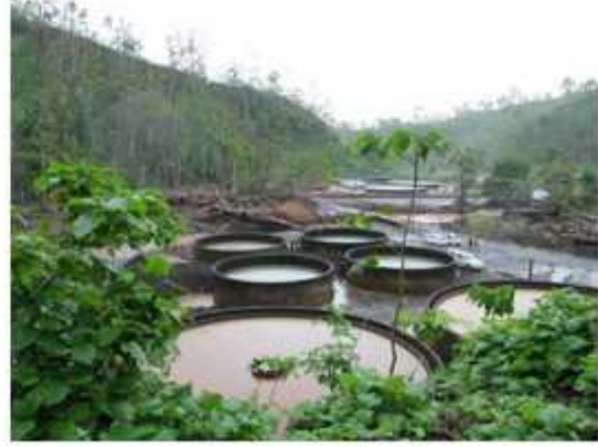
写真.濁水が流入した浄水場
