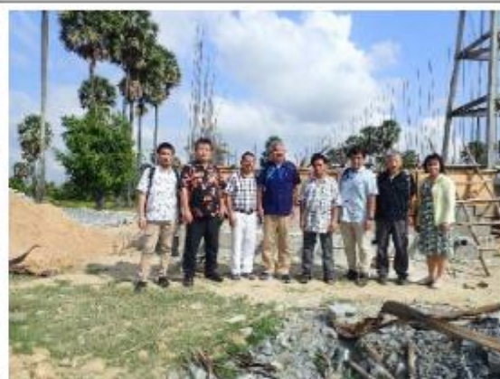
建設中の施設の前で集合写真
